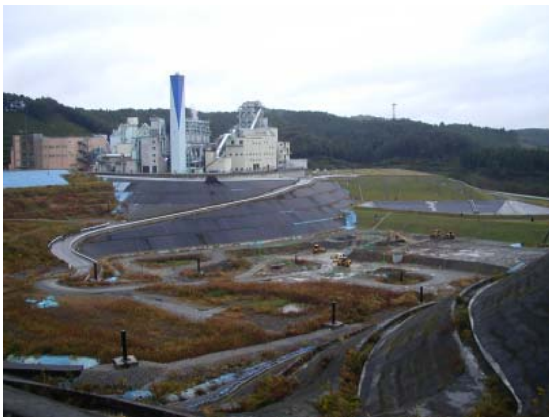
エコセメント化施設を外周道路から望む
